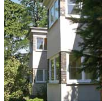
Nach der Fassadensanierung an der Goerzallee
