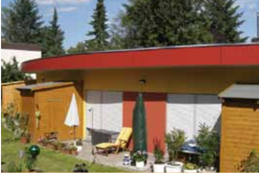
Neubau WA 71 in der Goerzallee
