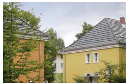
Nach der Fassadensanierung an der Goerzallee
