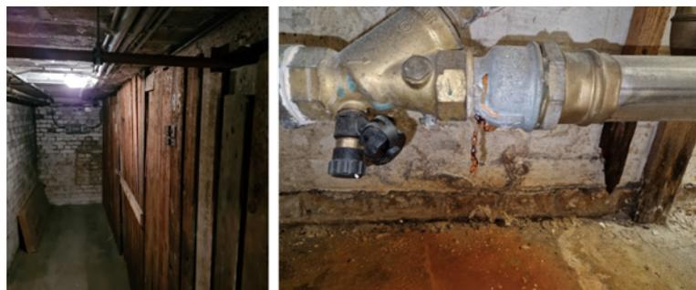
**Keller:** Alte Holzverschläge, alte Sanitärleitungen, Mischinstallation bei den Sanitärleitungen
